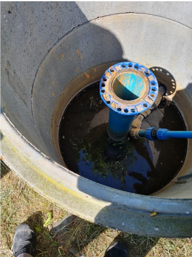
Boring, midlertidigt uden motor pga. motorsvigt. Ny motor i løbet af få dage.
